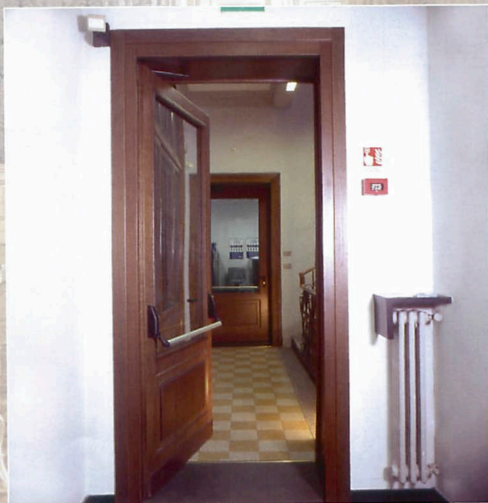
▶ Porte REI 60 a compartimentazione del vano scala dotate di maniglione antipanico. REI 60 stairwell doors with panic handle
