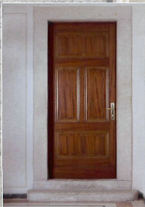
Porta bugnata a bassorilievo a formare cinque riquadri. Five-panel bas-relief masonry door.
